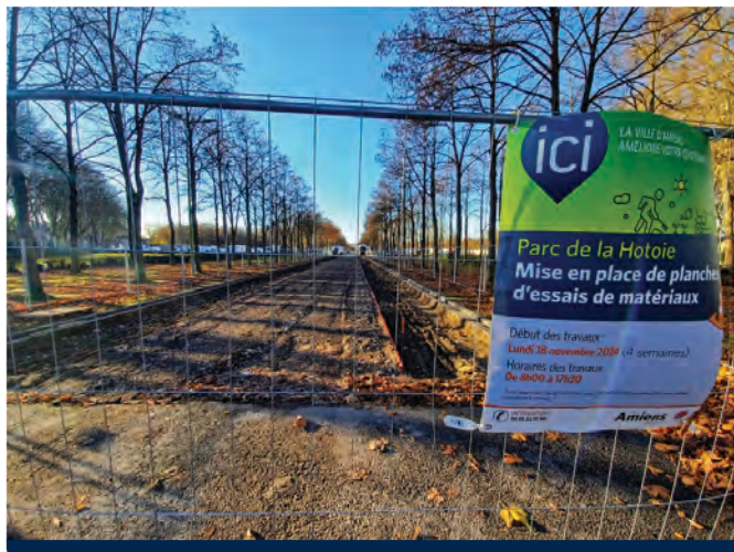
Chantier d'essais de matériaux sur le futur parc de la Hotoie
